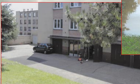
Zatopena byla přízemí bytových domů mezi ulicemi Kraslická a V Parníku
