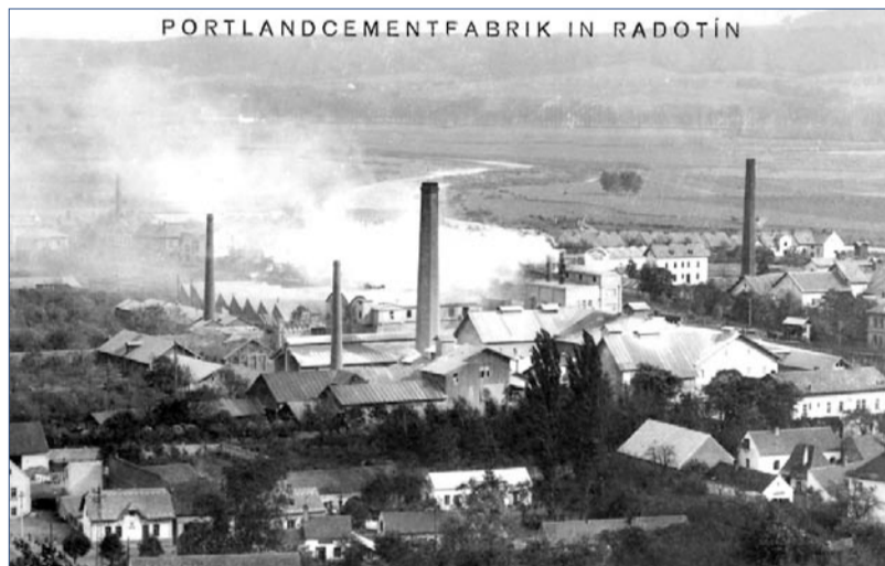
Radotínská cementárna v roce 1925
