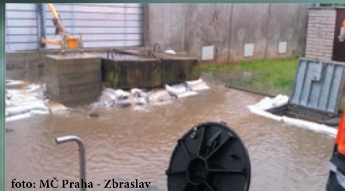
Selhání hradidlových komor za protipovodňovými zábranami na Zbraslavi alespoň částečně mírnily pytle s pískem zatížené betonovými panely
