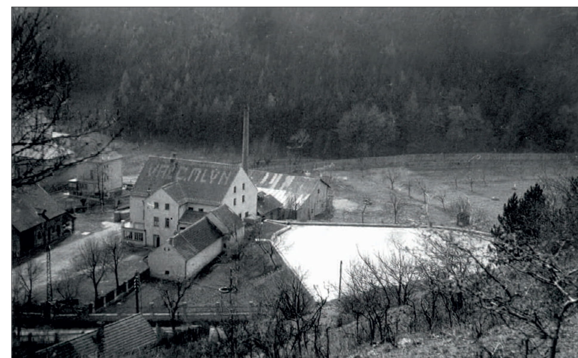
Ve 30. letech 20. století byl Böhmvův mlýn zrekonstruován na pilu, která byla roku 1948 znárodněna a následně zde vybudována Strojně traktorová stanice, dnes Střední odborné učiliště. Nádržka byla roku 1958 zasypaná zeminou, odkopanou při stavbě nové cementářské vlečky, která vede na druhé straně údolí
