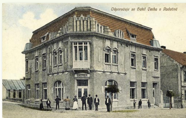
Už o rok později, LP 1911, si zde nechali František a Anna Cerhovi vystavět jednopatrový hostinec, 19.7.1912 jim bylo schváleno jeho užívání s tím, že stavebník „ani proti dráze, jak se průběhem doby přemění, tak i proti způsobu, totiž použití motoru na dráze této ničeho namítati nebude.“ Míněna byla úzkokolejka firmy Herget
