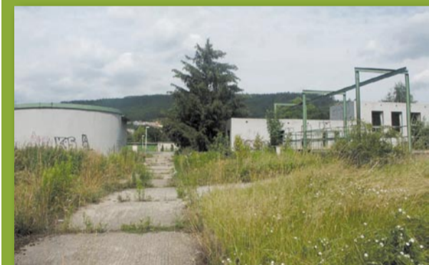
Opuštěná čistirna odpadních vod (2008)
