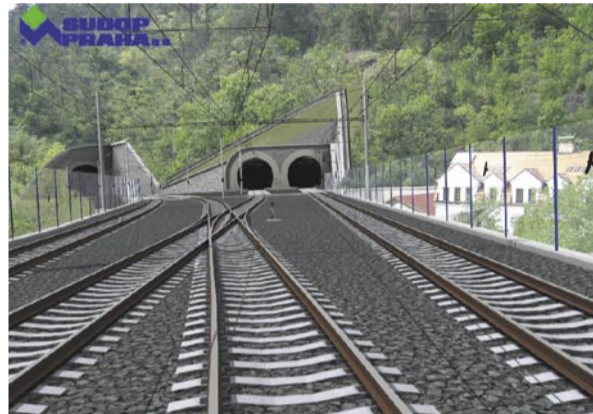
Portály Chuchle, vlevo odbočuje stávající trať do Radotína (ve výhledu dvojkolejná)
