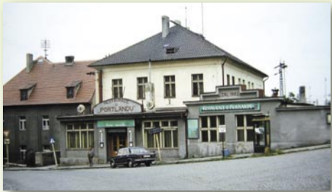
Fotografie z roku 1977 – ještě pět let poté se řešilo asi běžné bolavé místo radotínských pohostinství – žumpa – 19.5.1982 je zaznamenán propadlý strop fekální jímky (již 16.8.1951 přitom bylo paní Anně Pajmové nařízeno zrušení přepadu u žumpy)
