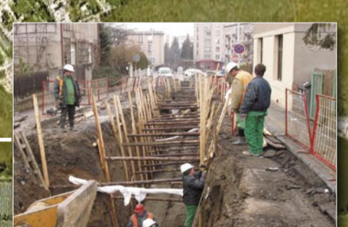
Úplné dokončení technické vybavenosti
