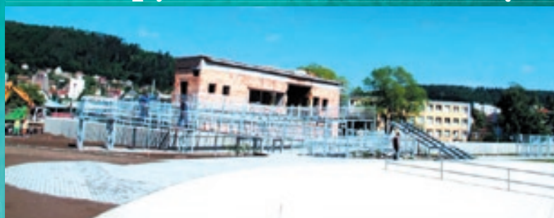
Provozní budova ještě nebude zcela hotová
