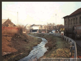
nežpevněné koryto potoka
