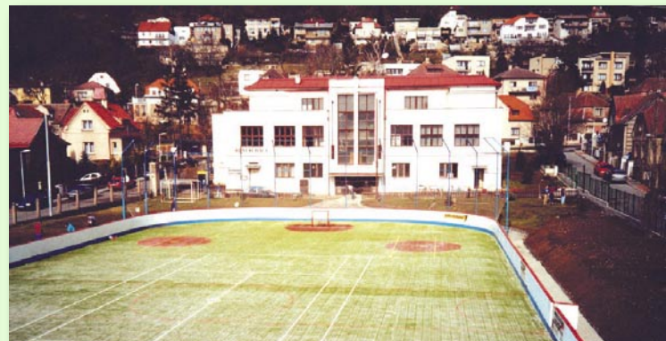
BŘEZEN 2001 – V TOMTO ROCE DOSTALA PLOCHA NOVÝ POUVRCH, NA FOTOGRAFII JE VIDĚT I NOVĚ NAVRSTVENÉ NÁSPY PRO BUDOUCÍ TRIBUNY. TY PRVNÍ BYLY PROVIZORNĚ SESTAVENY Z LEŠENÍ
